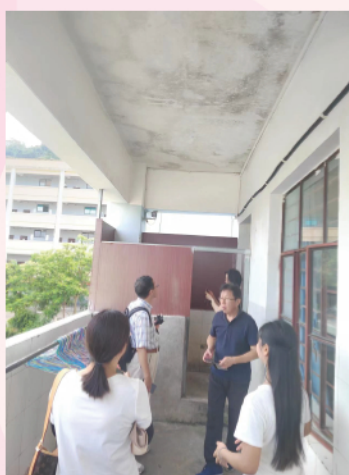
老朽化が著しい宿舎を視察
