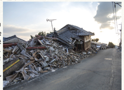
▲2017年1月30日現在 震災の傷跡が残る益城町
