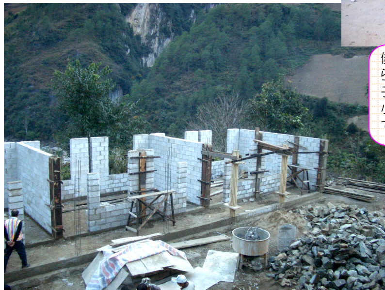
現在建設中の新校舎 2階建てです
