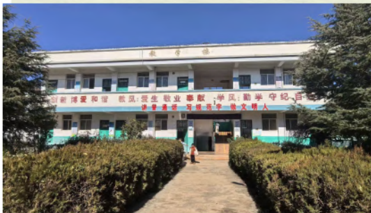
↑ 綺麗に大切にされている校舎
